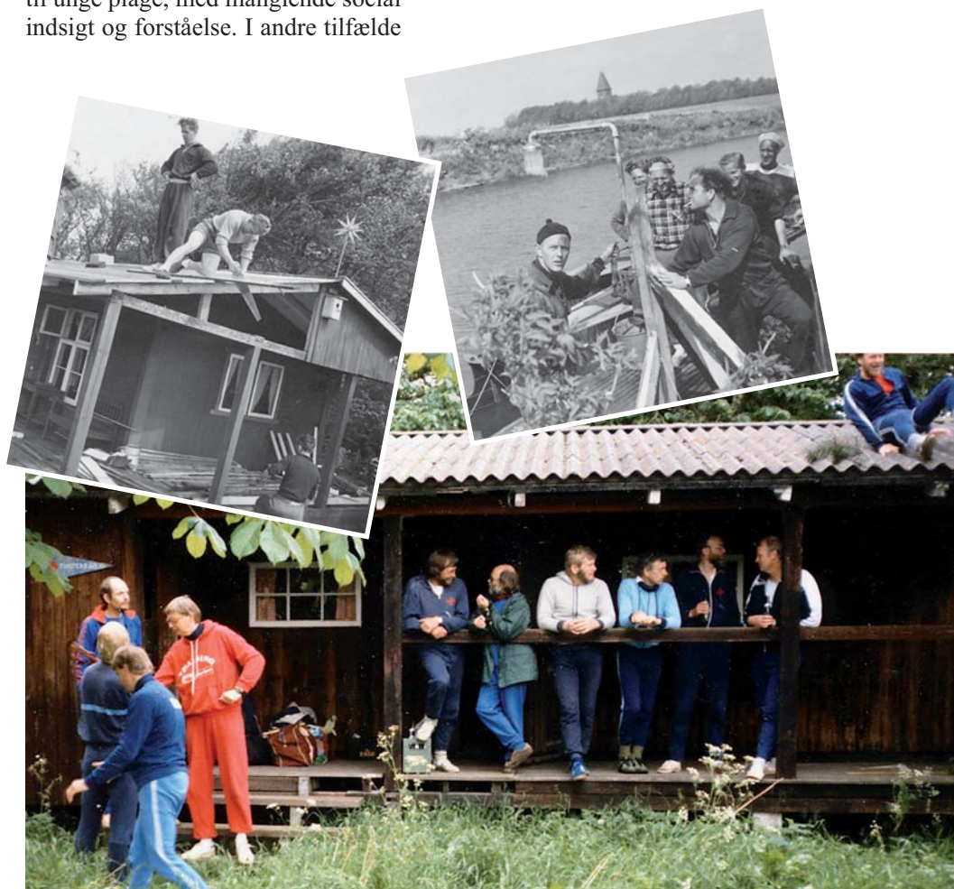
Glimt fra Trøstens Bolig: A) Tagreparation B) Etablering af Ryaa kurbad C) Kaproningslangtur 1986.
