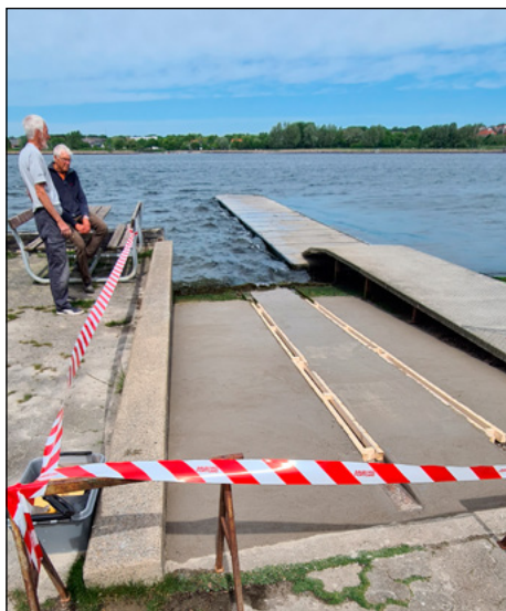
Det nyreparerede slæbested klar til brug.
