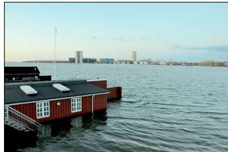
Oversvømmelser, som stormen Pia i 2023, kommer vi til at se mere til i fremtiden.
