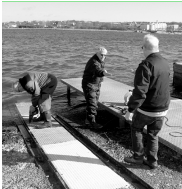
Down by the riverside - Smeden, Pottmesteren og Senior - revisoren monterer nye skridsikre dørkpladenet i slæbestedet.
